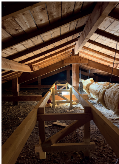
Rénovation thermique dans le plus ancien bâtiment de l'école du Pont Douar.
