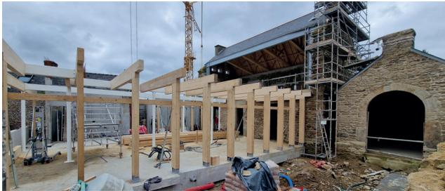
Les menuiseries sont posées à l'arrière du bâtiment. L'ensemble de la dalle du rez-de-chaussé est réalisée. 2024 verra s'élever le nouveau bâtiment aux tuiles vernissées blanches et le démarrage des travaux d'intérieur de la structure (électricité, plomberie...).
