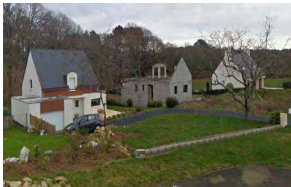
D120 / Rue du Moulin de Talhoed Construction des années 2010
