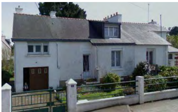
RD 765 / Rue nationale Construction des années 1960-1970
