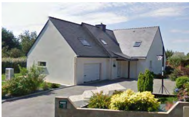
RD19 / Rue de Couëdic Construction des années 2000
